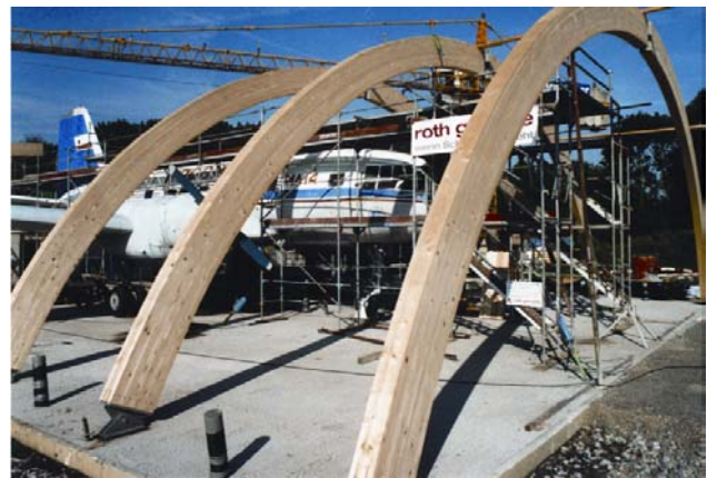
Brettschichtverleimte Dreigelenk- Bogenbinder bilden dem Rumpfteil entlang das ..... m weitgespannte Haupttragwerk des Baukörper für das „runway 34.“
