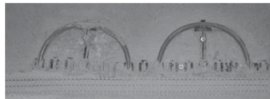
Abb. 9 In Rotkalk eingebettetes Wandheizregister
