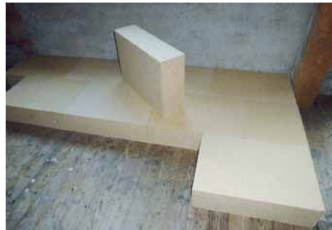
Abb. 16 Mit PAVAWALL-BLOC auf der obersten Geschossdecke werden alle Anforderungen der EnEV sicher erfüllt.
