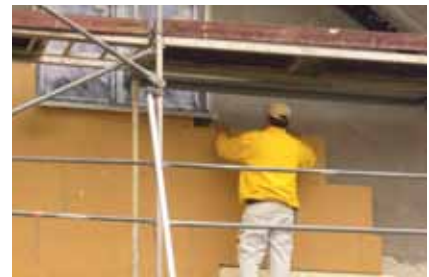
Abb. 3 Block für Block fugendicht und im Verband
