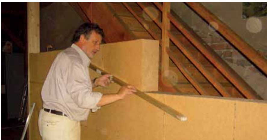
Abb. 12 Das Verarbeitungsprinzip ähnelt Mauerwerk-Plansteinen
