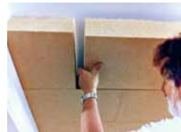
Abb. 15 Positionierung durch Heranschieben für beste adhäsive Anfangshaftung
