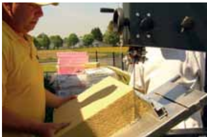
Abb. 1 Zuschnitt mit Holzbandsäge
