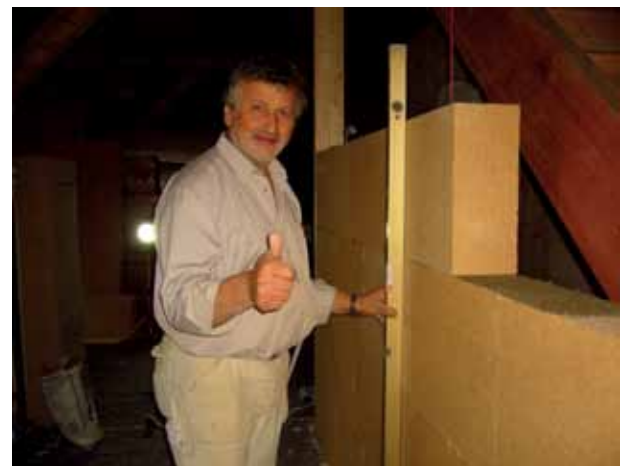
Abb. 13 PAVAWALL-BLOC ist als Drempelwand einfach und schnell zu verarbeiten
