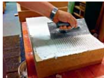
Abb. 14 Mit Zahntraufel aufgetragener Klebe- und Ansetzmörtel
