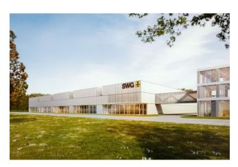
Die neue Halle der SWG Produktion hat beachtliche Abmessungen von114 m Breite auf fast 97 m Länge. Markant ist die Dachkonstruktion mit den Versprüngen zwischen den fünf Hallenschiffen. Eine Brücke verbindet die Produktionshalle mit dem dreigeschossigen Besucher-Pavillon. Der Entwurf stammt von Holzbau Stararchitekt Hermann Kaufmann (Visualisierung: HK Architekten)
