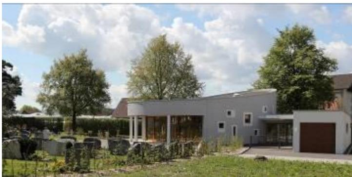
BU: Mit den Lignotrend Dachbauteilen LIGNO Akustik Q3 klassik BV für große Spannweiten konnte die geschwungene Pultdachgeometrie über dem elliptischen Grundriss der Aussegnungshalle Lottstetten präzise und wirtschaftlich realisiert werden.
