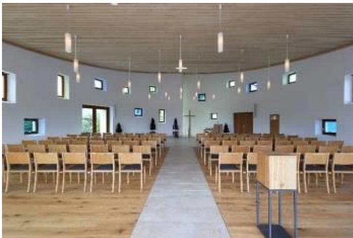
BU: Die 62,5 cm breiten und 35,5 cm hohen Holzbauteile von Lignotrend überbrücken Spannweiten von bis zu 12,5 m frei und sorgen dabei für eine homogene, durchgehend ebene Dachuntersicht.
