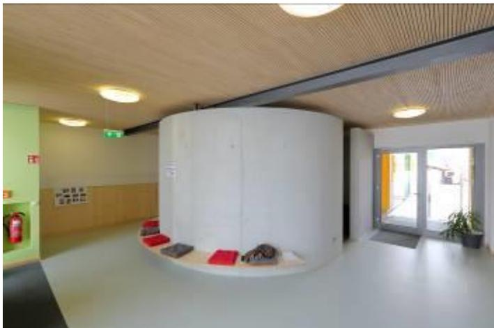
BU: Die als Halbrund betonierte „Schmutzschleuse“ wurde in Stahlbeton ausgeführt. Die Decken aus LIGNO Rippe Q3 Akustik bringen ab Werk die endgefertigte Echtholzuntersicht mit Akustikprofil schon mit.
