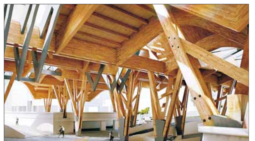
Die bis zu 30 m hohe Dachkonstruktion der U-Bahn-Station bilden doppelte BS-Holz-V-Stützen, -Träger und verschieden ausgeformte Bogenbinder. Foto: Miralles Tagliabue EMBT Architekten
