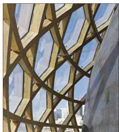
»La Seine Musicale«: Gitterkonstruktion aus zweifach gekrümmten BSH-Gitterstäben Foto: Didier Boy de la Tour
