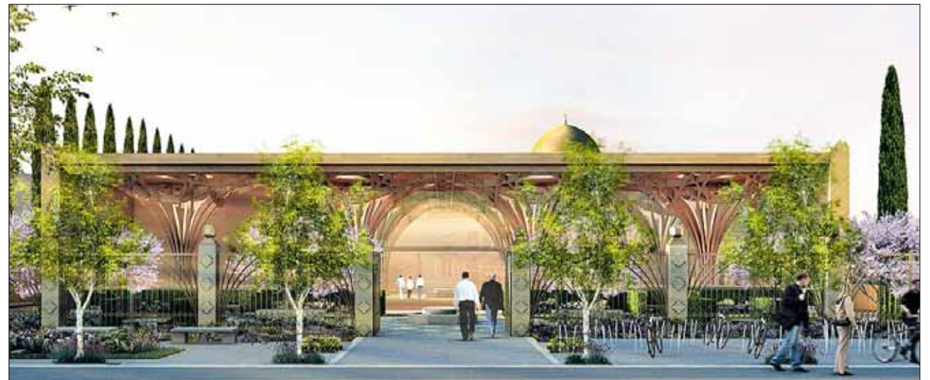
30 frei geformte baumartige Holzstützen bilden zusammen mit der Deckenstruktur das Haupttragwerk der neuen Moschee in Cambridge (Großbritannien). Sie fasst 1000 Gläubige. Visualisierung: Marks Barfield Architects London
