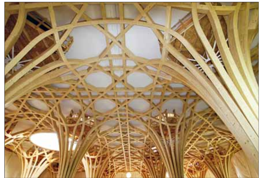
Gebogene BS-Holz-Stäbe wurden zu Stützen gebündelt, die sich wie Bäume nach oben öffnen und in das netzartige Muster der Decke übergehen.
