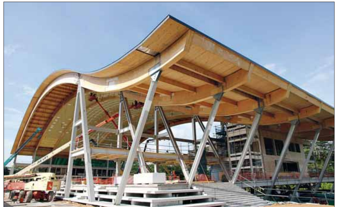
Sieben BS-Holz-Bögen aus je drei Teilen überspannen die 72 m breite Sporthalle der Nanyang Technological University (NTU) in Singapur. Sie stützen sich jeweils in drei Punkten, unter anderem auf A-förmigen Stahlrahmen, ab. Fotos: Binderholz (2)
