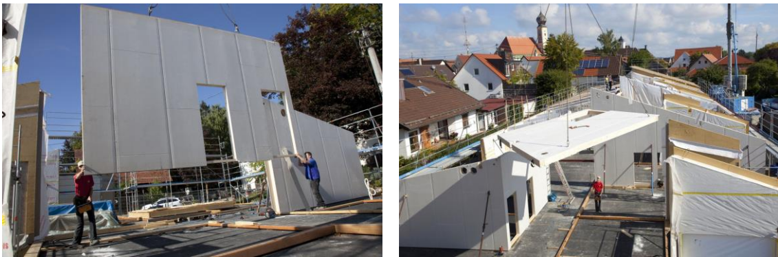
Aufbau der einzelnen Elemente des Holzbaus vor Ort
