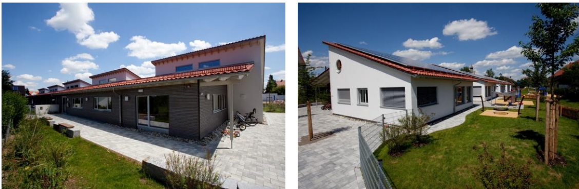
Außenansichten der neuen Kita in Pfaffenhausen: Hinterlüftete Fassadenverkleidung aus Holz (links) und Solarpanels auf dem Dach (rechts)
