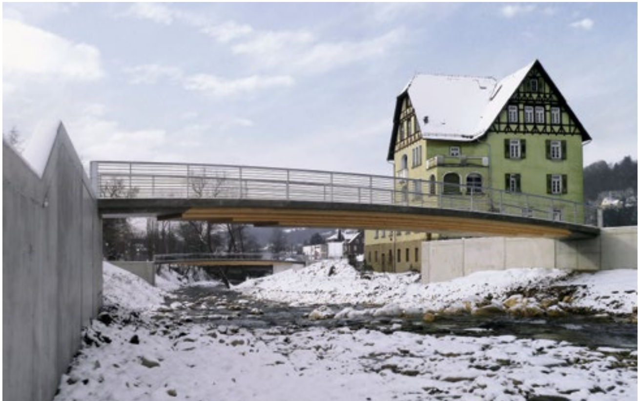
Das Rahmentragwerk aus Holz und Beton in integraler Bauweise führt die Tradition der Holzverbundbauweise innovativ weiter.
