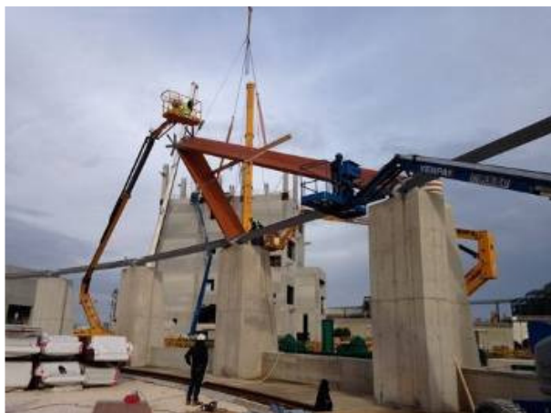
Abbildung 8: Phase der Fertigstellung des ersten Trägerpaars am ersten Ring des Haupttragwerks
