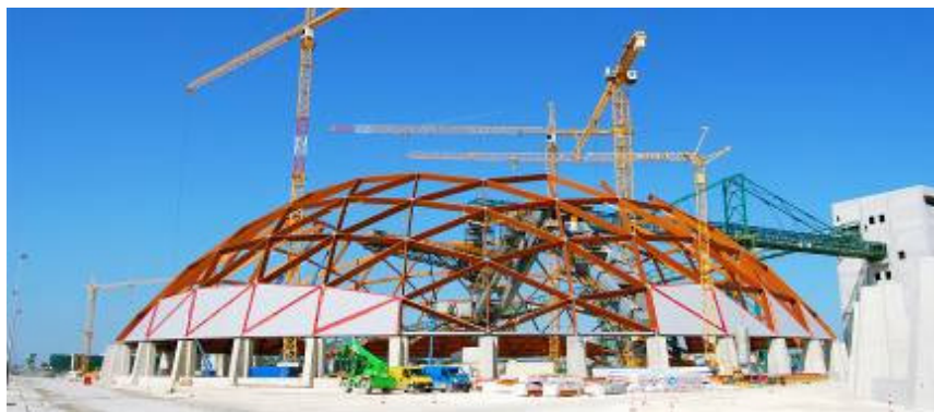
Abbildung 11: Ansicht der gesamten Kuppel, die den aktuellen Stand des Montagefortschritts zeigt
