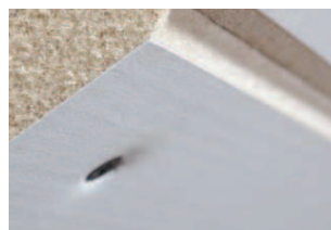
Abb. 2: Versenkter Schraubenkopf
