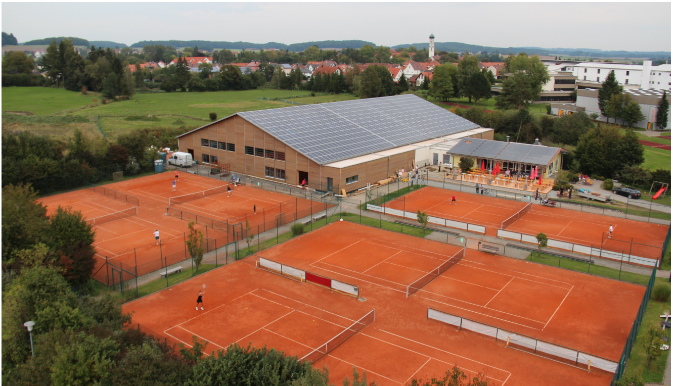
Abb 1. Neue Drei-Feld-Tennishalle mit Wohlfühlklima: GUTEX Holzfaserdämmung in Dach- und Wandaufbau (Quelle: Holzbau Walser).
