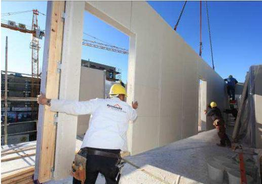
Die hochfeuerhemmende Knauf System-Außenwand erreicht die Klassifizierung K<sub>2</sub>60. Mit der geprüften Systemlösung lassen sich Holzständer-Außenwände besonders raumsparend und wirtschaftlich realisieren. (Foto: Knauf/Ducke)
