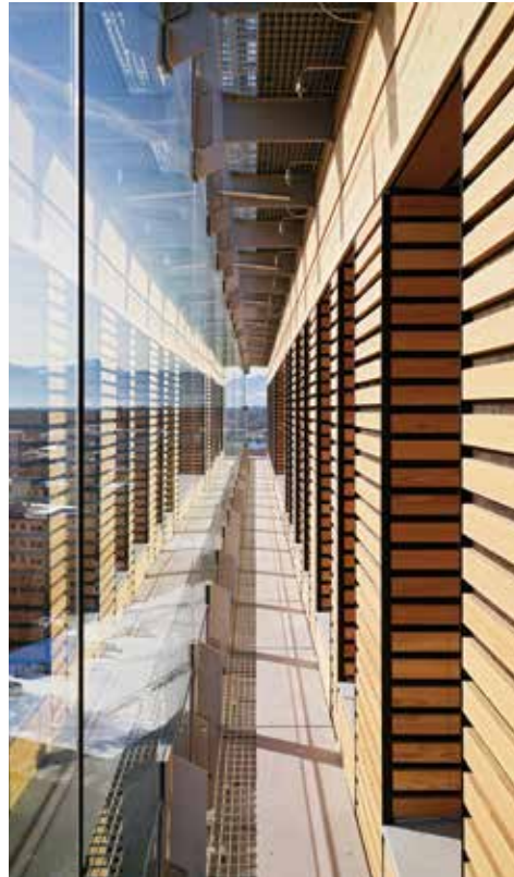
Die Fensterbänder wurden ersetzt durch Lochfenster. Die Fassadenschichtung ermöglicht ein individuelles Öffnen der Flügel und das Schaffen eines «Zwischenklimas».
