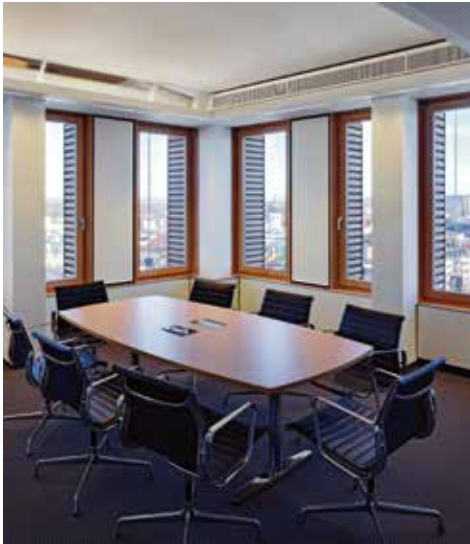
Die Fensterbänder wurden ersetzt durch Lochfenster. Die Fassadenschichtung ermöglicht ein individuelles Öffnen der Flügel und das Schaffen eines «Zwischenklimas».
