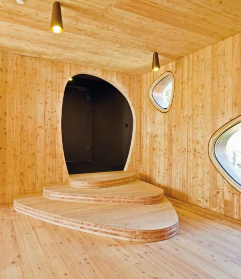
▲ Die Brettsperrholzplatten ermöglichten eine fantasievolle Gestaltung mit organischen Formen
