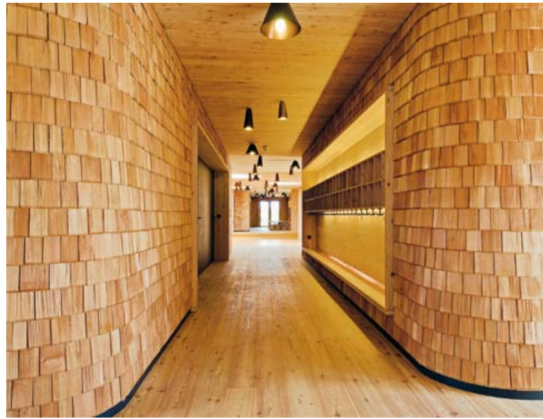
▲ Die Lärchenschindeln sind auch in den Erschließungsbereichen angebracht, dort wegen der Spreißel aber mit einer Bürste etwas geglättet
