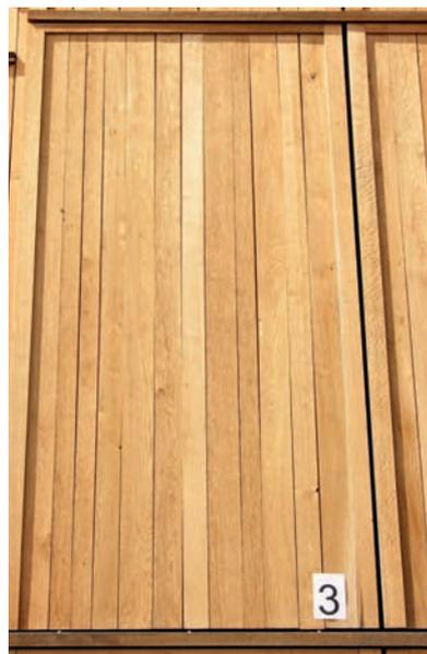
**Abb. 5:** Detail: Ungleichmässige Verwitterung an der Eichenfassade und Wasserränder (links) und die gereinigte, homogene Fassade (rechts).
