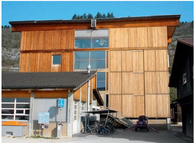
Werden unbehandelte Fassaden eingesetzt, so werden diese in der Regel dem Verwitterungsprozess überlassen und es wird angenommen, dass mit der Zeit ein gleichmässiges Erscheinungsbild entsteht. Dies ist allerdings abhängig von der Exposition und Konstruktion und nur in seltenen Fällen gewährleistet. In breiten Teilen der Bevölkerung führt dies aber zu einem schlechten Image von Holzfassaden, was ihren verstärkten Einsatz einschränkt.
