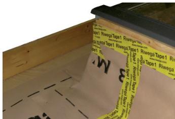
Dachfenster abgedichtet mit Klebeband USB Tape 1 PAP
