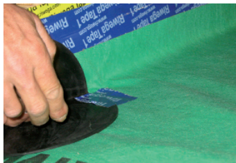
Abdichtung mit Klebeband USB Tape 1 PE
