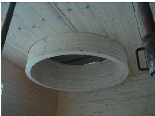
Brettschichtholzplatten mit Treppenwechsel
