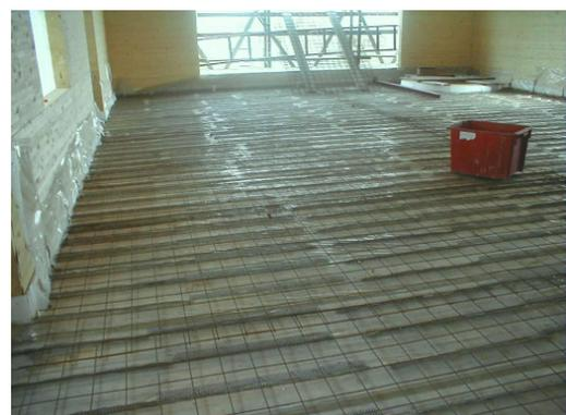
Brettschichtholzplatten mit HBV®-Schubverbindern
