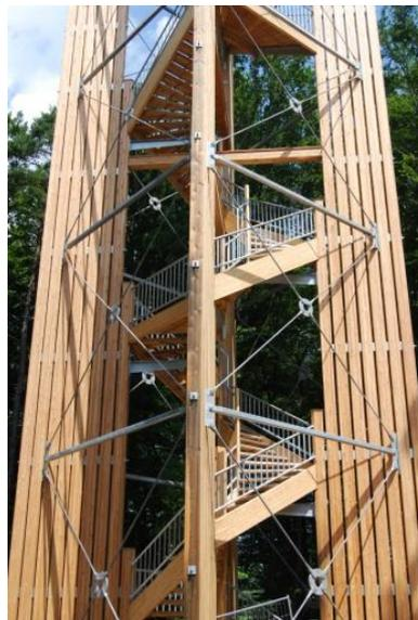
Den Erfordernissen der Statik entsprechend weisen beim Holzturm Altberg die vier Hauptstützen im Fundamentbereich die grösste Dimensionierung des Verbundes auf. Nach oben hin nimmt die Zahl der zusammengesetzten Stützen ab, was eine Verschlankeung ergibt.
