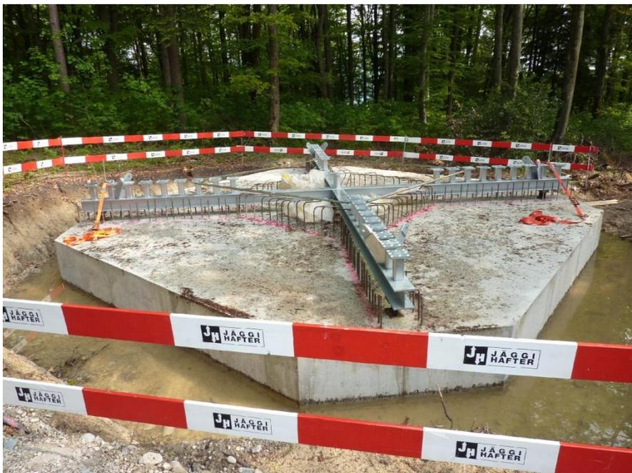
Kreuzförmig angelegt sind die Fundamente mit den Verankerungen für die zusammengesetzten, brett-schichtverleimten Palisadenstützen aus Lärchenholz.
