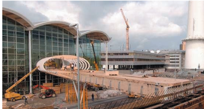
5 Errichtung der Brücke © Holzbau Amann GmbH
