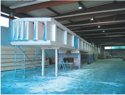
3 Vorfertigung im Werk © Holzbau Amann GmbH
