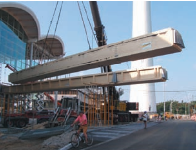
4 Montage der Kastenträger © Holzbau Amann GmbH
