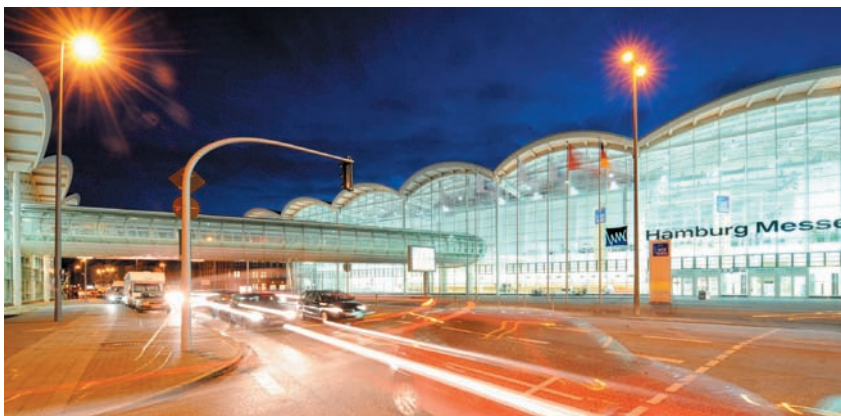
6 Fertiggestelltes Bauwerk bei Nacht © HCM/Michael Zapf
