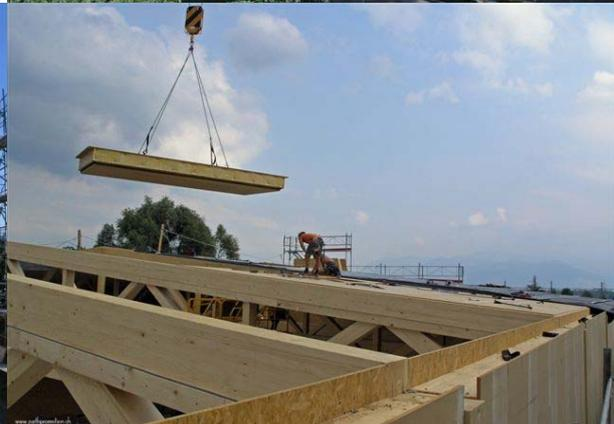
Ausgehend von den Projektvorlagen (Schnitt, oben links) erfolgte die bauliche Umsetzung mit stabförmigen Holzbauteilen (Dachträger) und vorfabrizierten, wärmegeämmten Dachelementen (unten, rechts).
