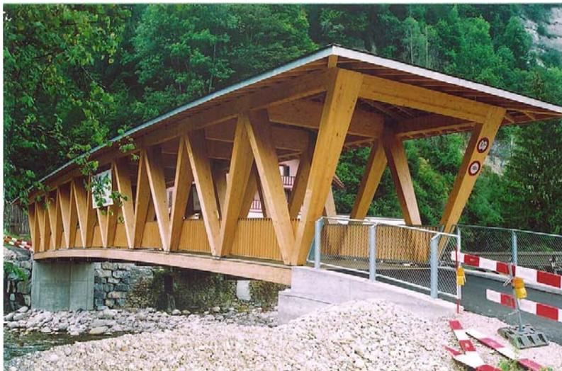
Die neue, 33,3 m weit über den Flusslauf der Kleinen Emme gespannte Badbrücke dient nicht nur Fussgängern und Radfahrern, sie ist auch für Fahrzeuge bis zu einer Gesamtlast von 10 Tonnen ausgelegt.
