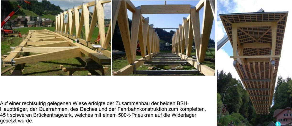
Auf einer rechtsufrig gelegenen Wiese erfolgte der Zusammenbau der beiden BSH-Hauptträger, der Querrahmen, des Daches und der Fahrbahnkonstruktion zum kompletten, 45 t schweren Brückentragwerk, welches mit einem 500-t-Pneukran auf die Widerlager gesetzt wurde.
