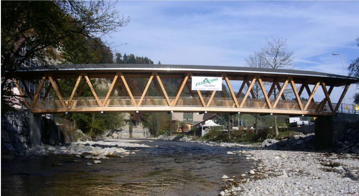
Im Gegensatz zu ihrer vom Hochwasser zerstörten Vorgängerin, einer weitgehend geschlossenen Kastenbrücke in Holzbauweise, ist für den Neubau der Badbrücke bei Wolhusen eine Ausführung mit einer gedeckten, transparent gestalteten Holzfachwerk-Konstruktion gewählt worden.
