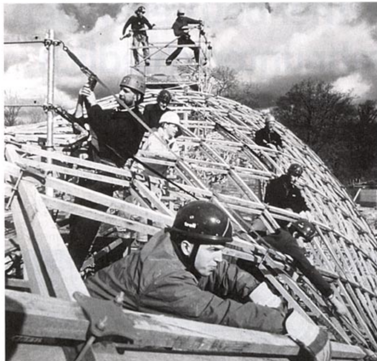
Eindrucksvoll: Bau eines Gitterschalendachs aus Eichenholz für das Open Air Museum in Sussex, England.
