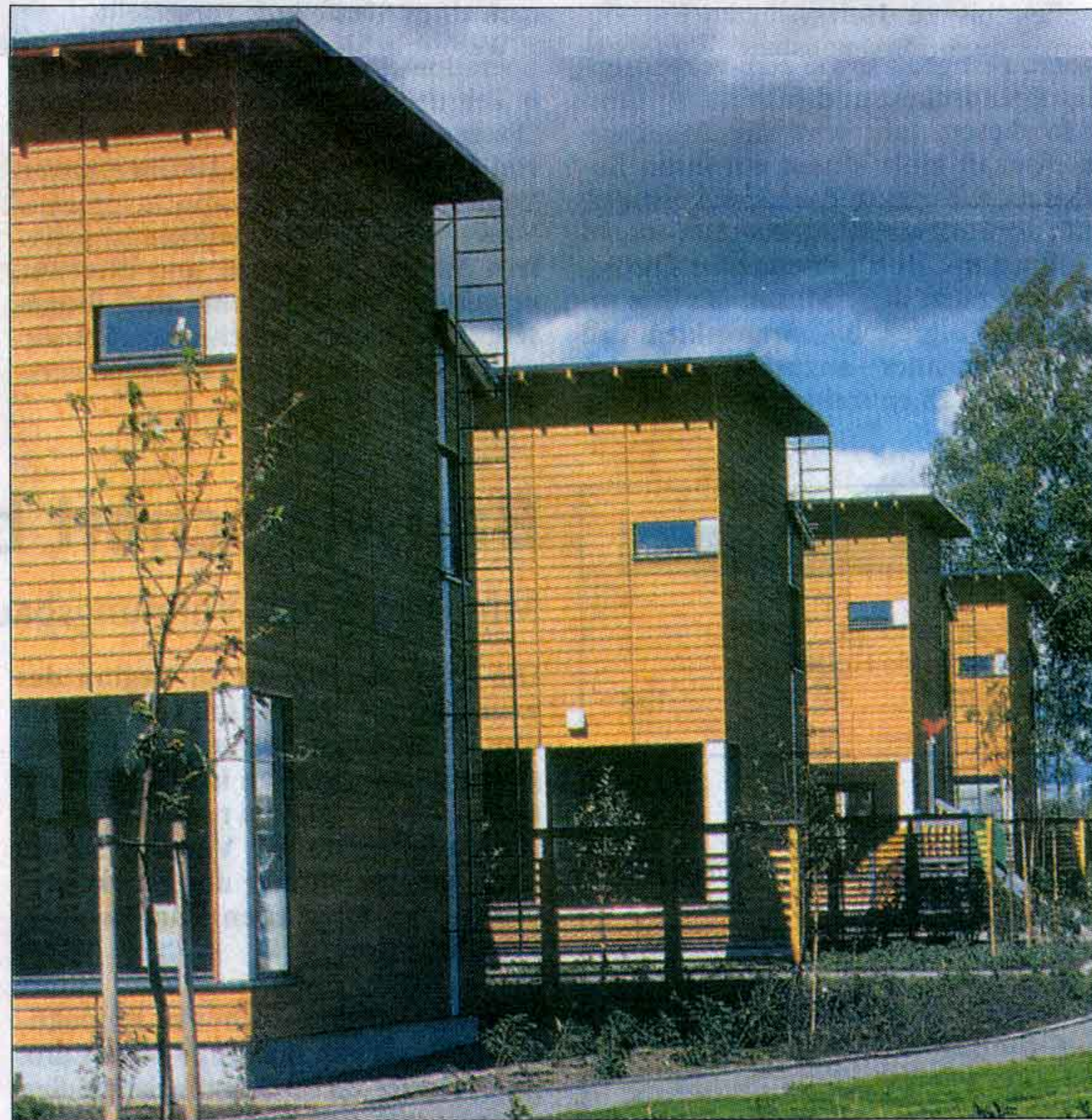
Auch Finnland will den mehrgeschossigen Wohnungsbau aus Holz im eigenen Land stärker forcieren – hier abgebildet ein neues Holzbauviertel in Tuusulan, einem Vorort von Helsinki.
